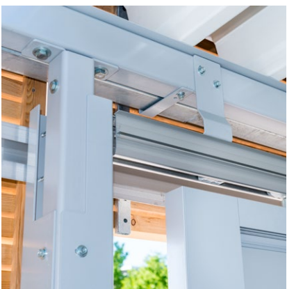
SCHIEBETÜR schwellenlos, platz- und raumsparend, wartungsfrei, mit obenliegender Laufschiene, leichtgängig und geräuscharm, auf Wunsch abschließbar.
